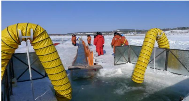
图 B-19 冰下流水处的布设围油栏布设示意图
