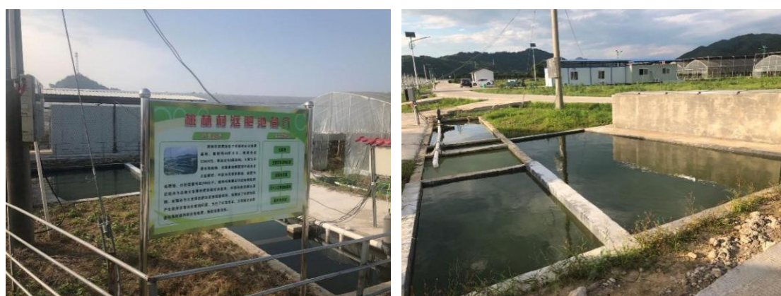
图 5-5 寨里镇桃林村沤肥池建设情况
