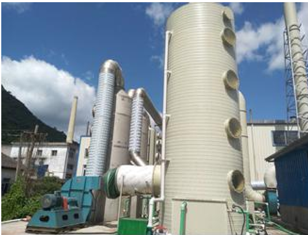
图 5-13 海圣饲料尾气处理设备
