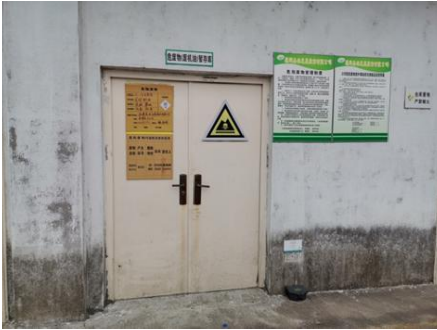
图 10 圣农公司危废暂存库
