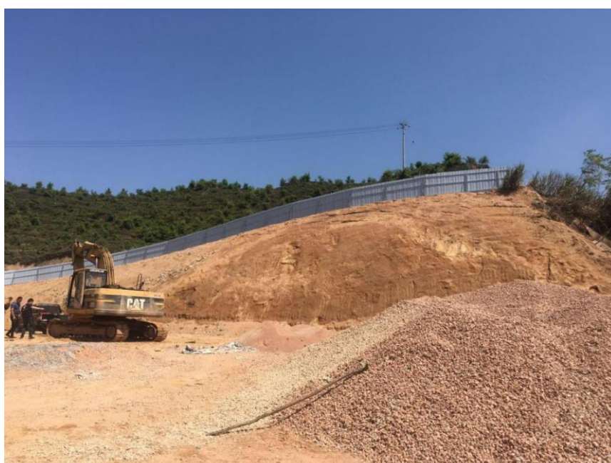
图8 光泽县建筑垃圾消纳场建设现场
